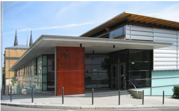
Die Sporthalle besteht aus der dreiteilbaren Halle und dem zweigeschossigen Nebenraumbereich mit Umkleiden, Technik, Geräteräumen und Erschließung. Das gekrümmte Hallendach erhielt eine Metalldeckung, das Flachdach des Nebenraumgebäudes ist extensiv begrünt.
